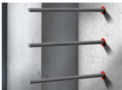
Dodatočné vlepovanie výstuže
